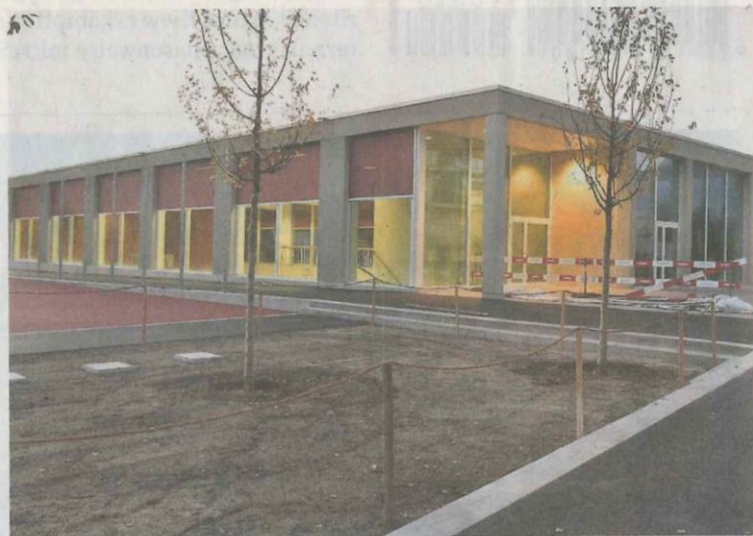
Die fertige Halle: Investiert wurden 4,26 Millionen Franken.
