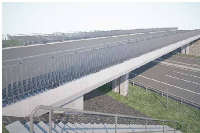
Die neue Autobahnüberführung der Kantonsstrasse Luterbachstrasse.
