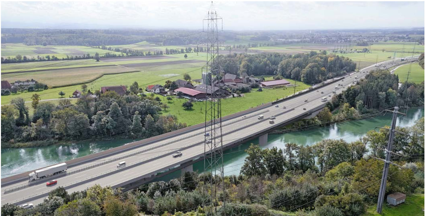
Am unteren Bildrand die neue Autobahnbrücke mit 3 Streifen.
