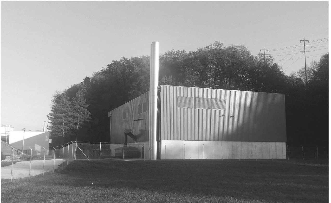
Zentrale der Fernwärme
